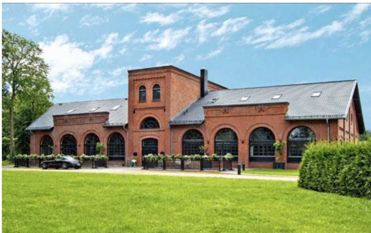
Zum Wohn- und Geschäftshaus umgebaute ehemalige Fabrik - neu bedacht mit Stahlpfannen
