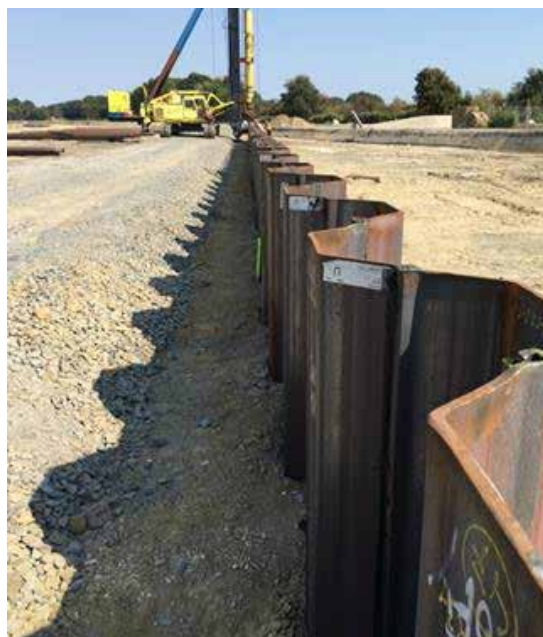
Bild 9: Blick auf Spundwandverbau
