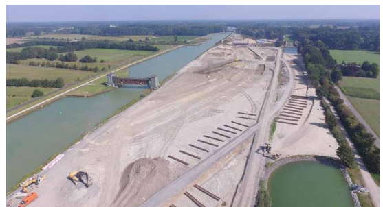
Bild 4: Baustraße / Arbeitsebene entlang der späteren Verbau-Trasse mit bereits ausgelegten Spundwänden
