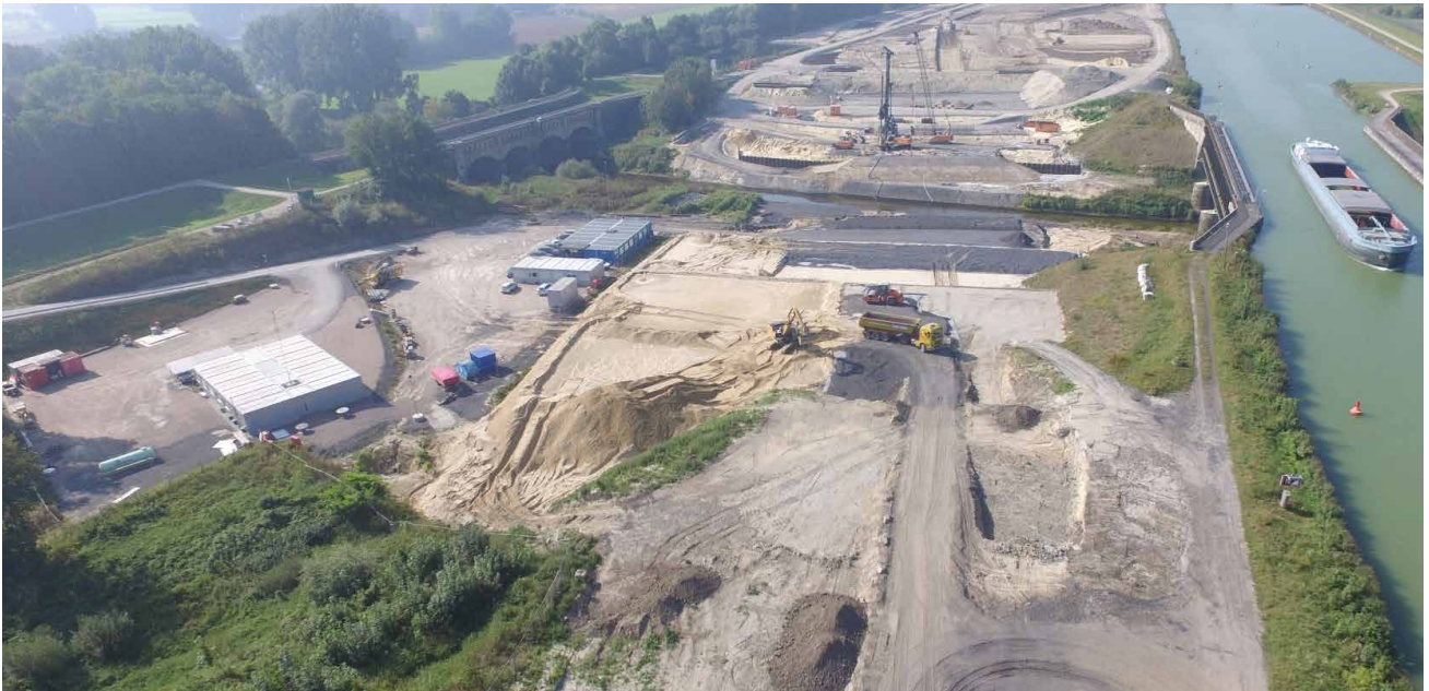
Bild 2: Blick über das Gesamt-Baufeld
