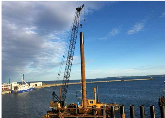
Bild 6: Einbau Tragrohre
