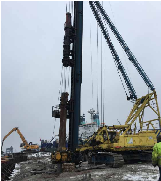
Bild 7: Einbau Ortbetonrammpfähle
