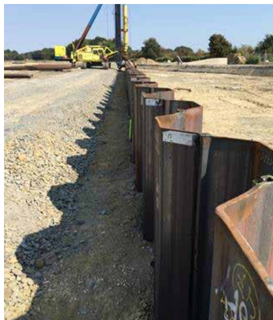
Bild 9: Blick auf Spundwandverbau
