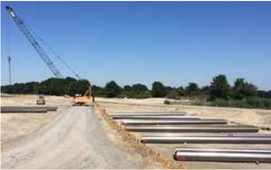
Bild 5: Auslegen der Spundwände entlang der Trasse mittels Seilbagger
