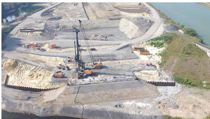
Bild 10: Bohrpfahlarbeiten am Widerlager Süd
