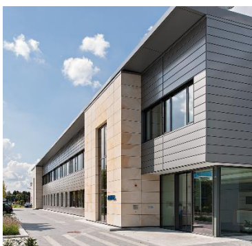
Betriebsgebäude der Denios AG mit Steckpaneelsystem aus Stahlblech (Quelle: Architekt: Gottfried Kasel, Foto: Peter Hübbe)
