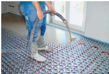
Nach dem Verlegen der Wabenplatten erfolgt der Verguss mit Fließestrich (Quelle: Wirtschaftsvereinigung Stahl)
