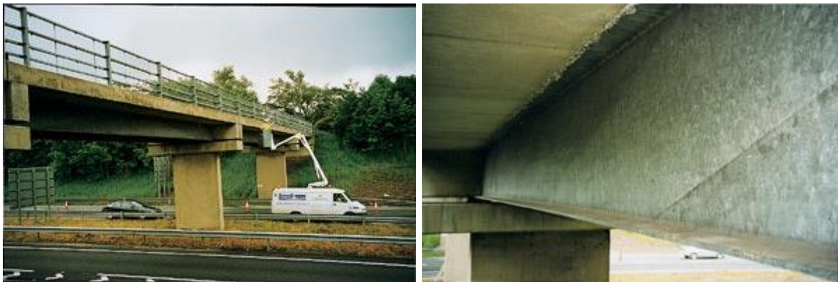
Abbildung 1.1: Feuerverzinkte Autobahn-Überführung bei Stainsby Hall, UK Figure 1.1: Hot-dip galvanized highway crossover near Stainsby Hall, UK
