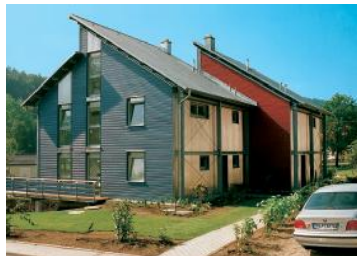
Die Funktionsräume des Doppelhauses befinden sich auf der Nordseite.
